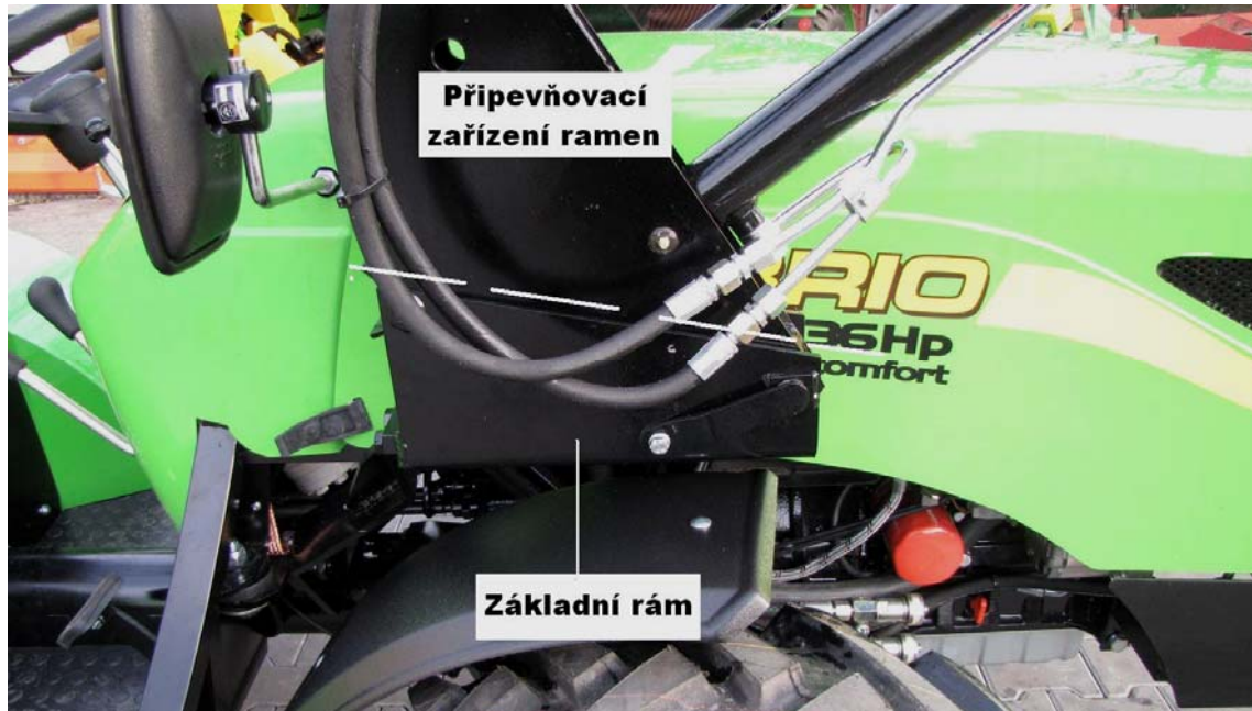
montáž základního rámu
